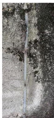
N° 23 Conducteur au sol non protégé, abîmé et percé
